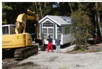
トレーラーハウスの搬入・設置
