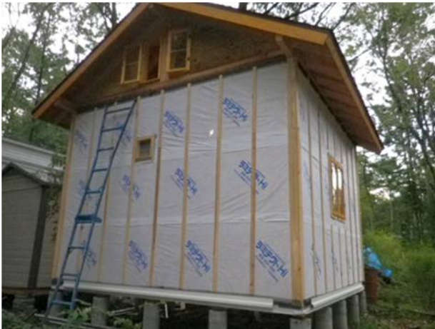
2011 年 9 月外壁貼りの準備
