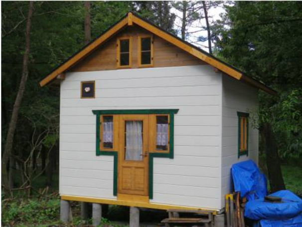
2012 年 10 月 ほぼ完成。妻壁の壁材は杉板を使用
