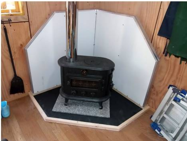
2014 年 4 月 薪ストーブ設置完了。 試運転はこの秋に
