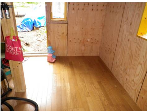
2012 年 7 月 床貼り完成
