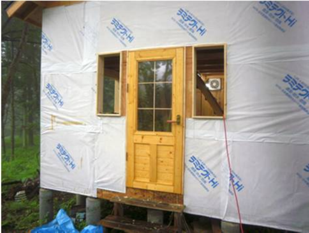
2011 年 6 月 ドアも 2*4 材とアクリルで作成し取付窓も作成。
